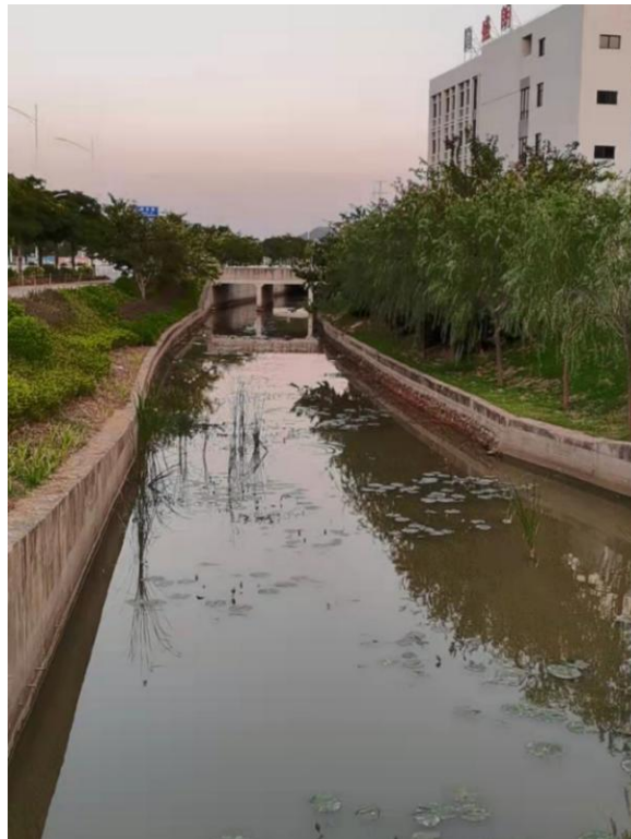
改造后现场图（局部）
