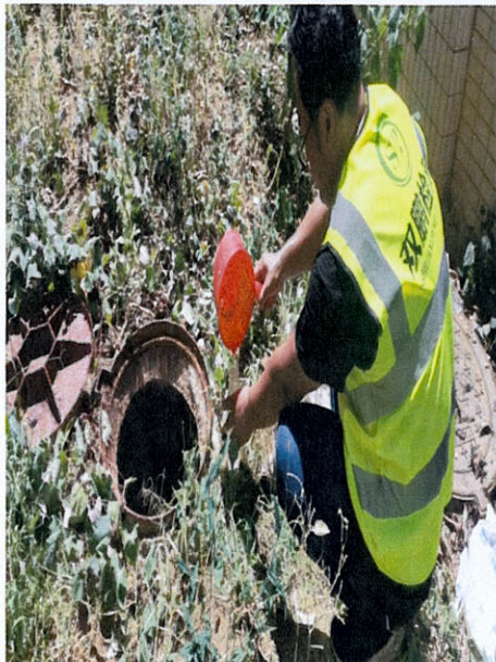
生活污水处理后采样口
