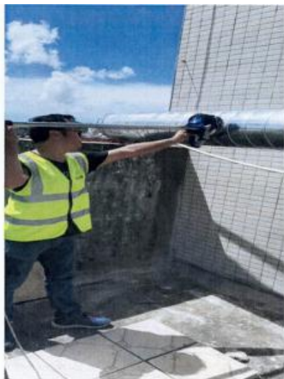
厨房废气处理前采样口
