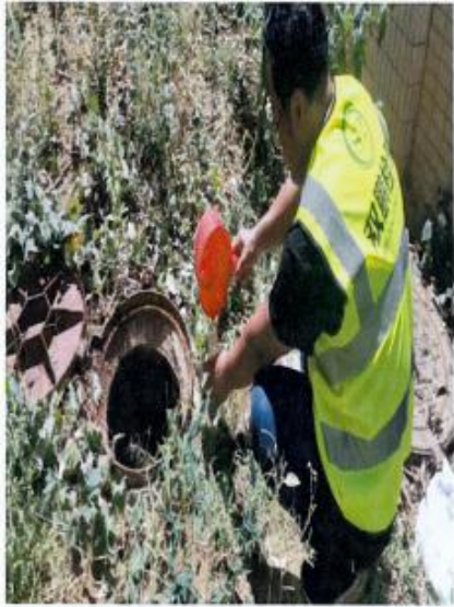
生活污水处理后采样口
