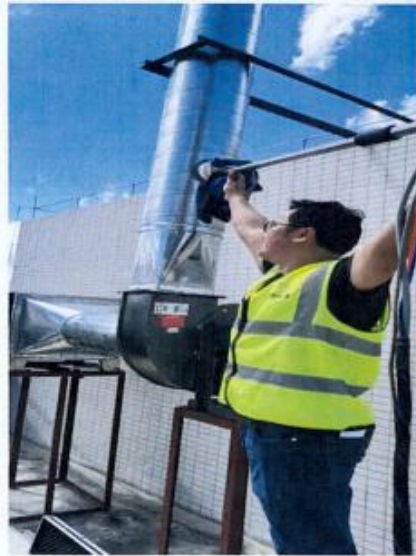
有机废气处理后采样口
