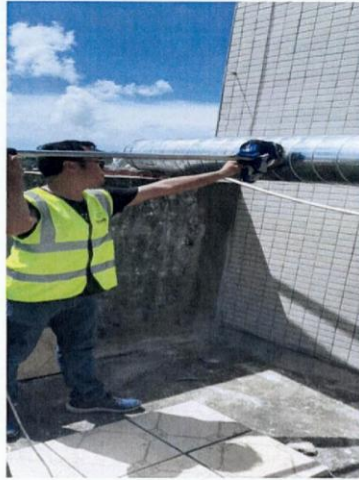
厨房废气处理前采样口
